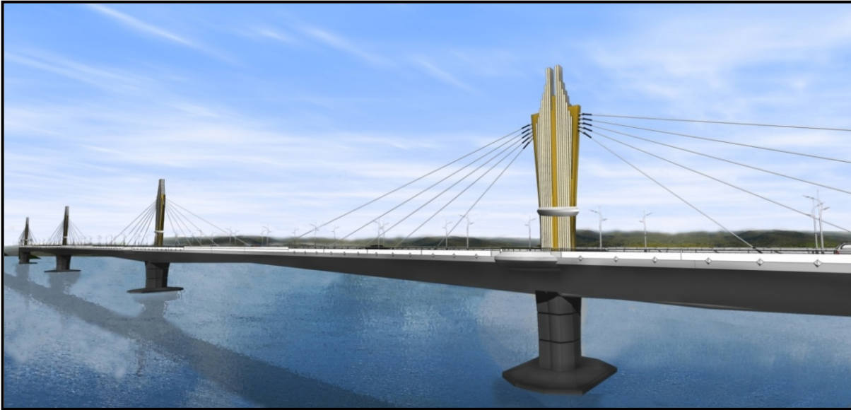
รูปที่ 3.37 รูปแบบเสาหลักของสะพาน (Pylon) ประยุกต์ระหว่างสัจจะของโครงสร้างและ “แคน”
