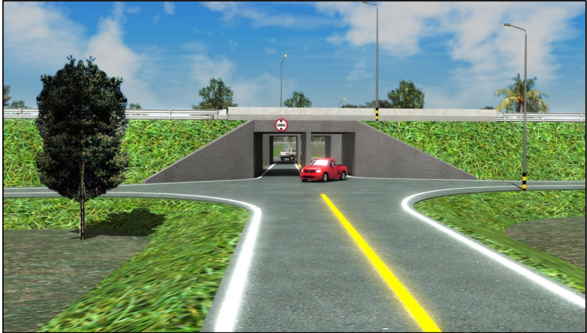
รูปที่ 3.11 รูปแบบทางลอดแบบ Underpass Box สำหรับจุดตัดถนนท้องถิ่น
