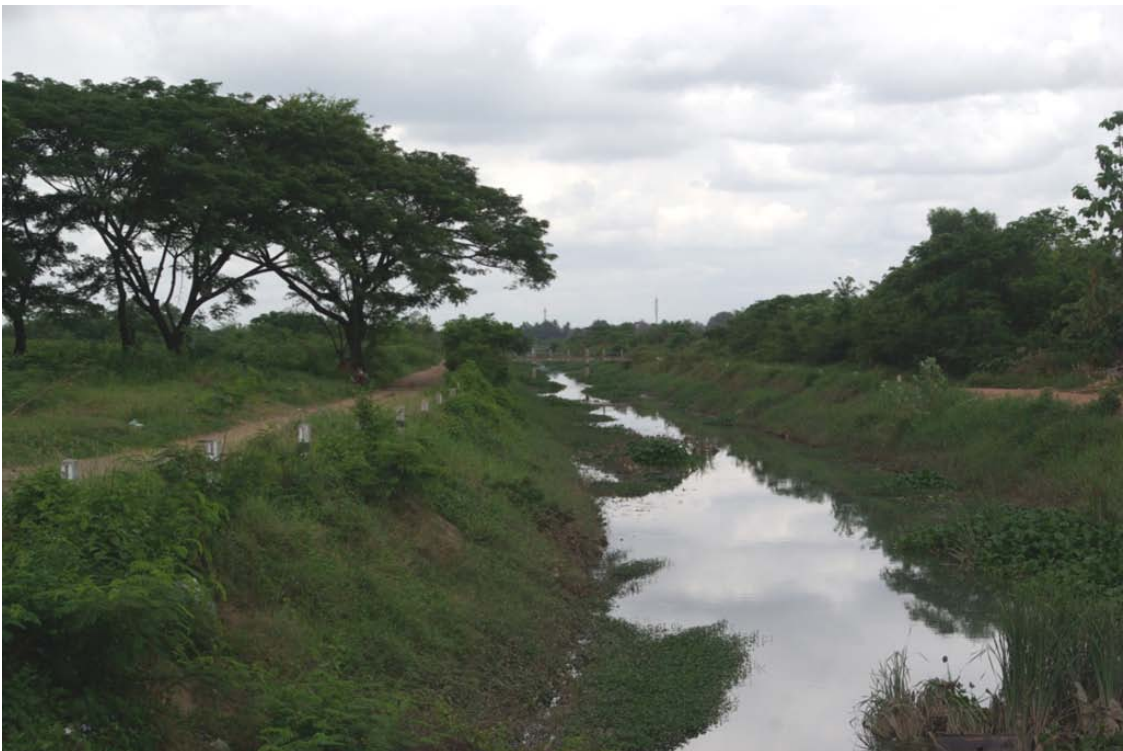
รูปที่ 3.5-2 ลักษณะของร่องระบายน้ำ
