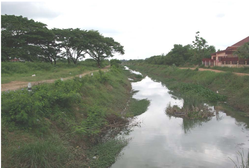
รูปที่ 2.14-2 สภาพของร่องระบายน้ำบริเวณโครงการ
