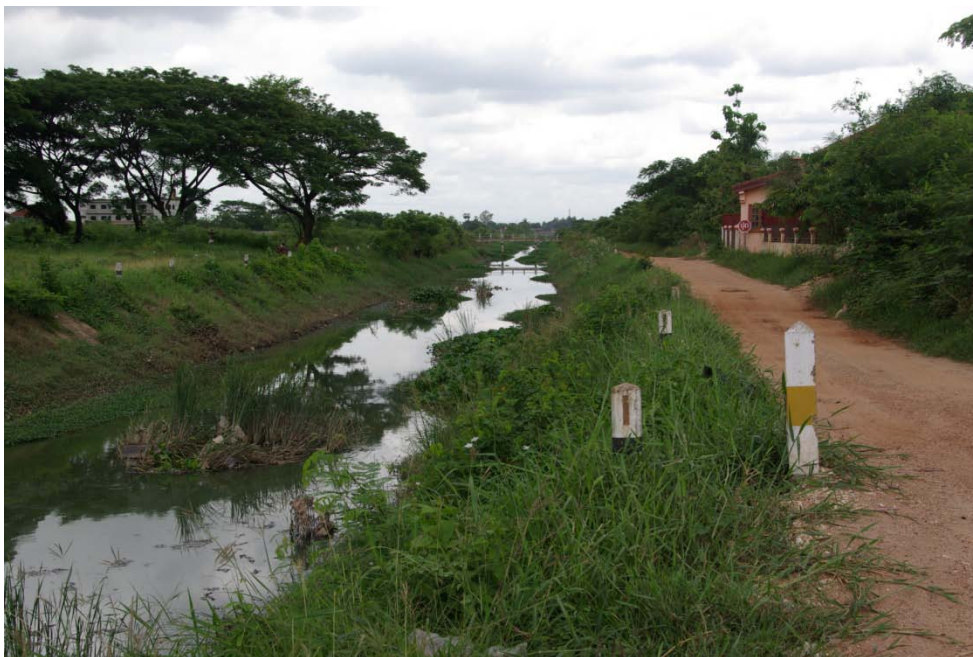
รูปที่ 2.14-4 สภาพถนนริมร่องระบายน้ำบริเวณโครงการ
