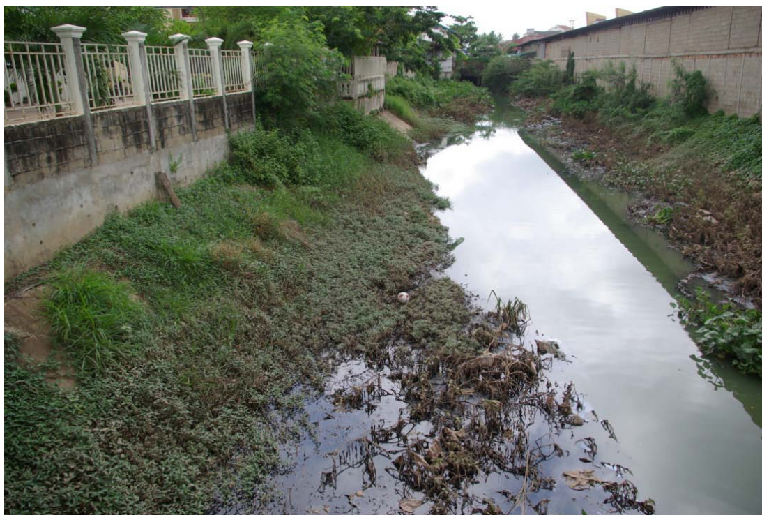
รูปที่ 3.5-3 การทิ้งน้ำเสียและคราบน้ำมันบริเวณร่องระบายน้ำ
