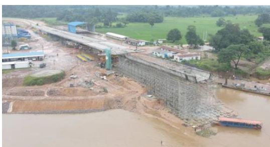
ภาพการก่อสร้างสะพานมิตรภาพ แห่งที่ 5
