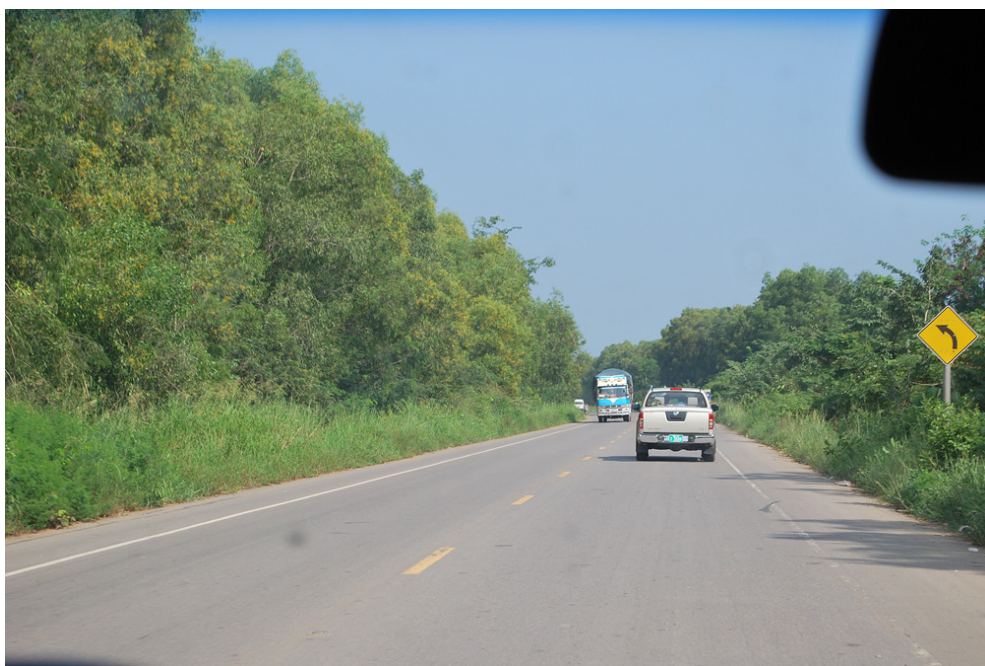
รูปที่ 4.5 ทางหลวง NR5 ปอยเปต-ศรีโสภณ กม.402-401 (ทิศมุ่งตะวันออก)
