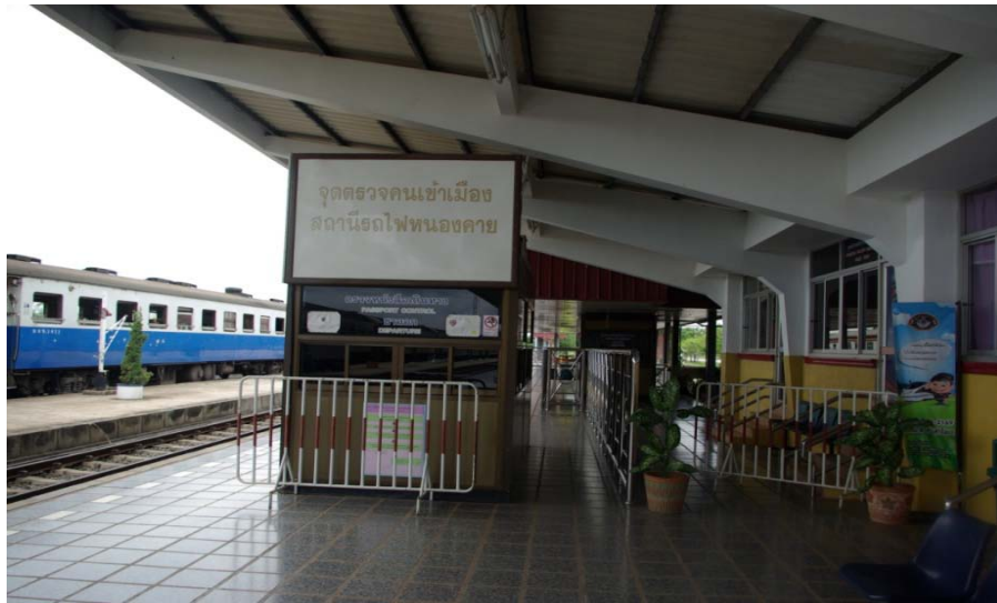
รูปที่ 2.6-2 สถานีรถไฟหนองคาย บริเวณด้านตรวจคนเข้าเมือง
