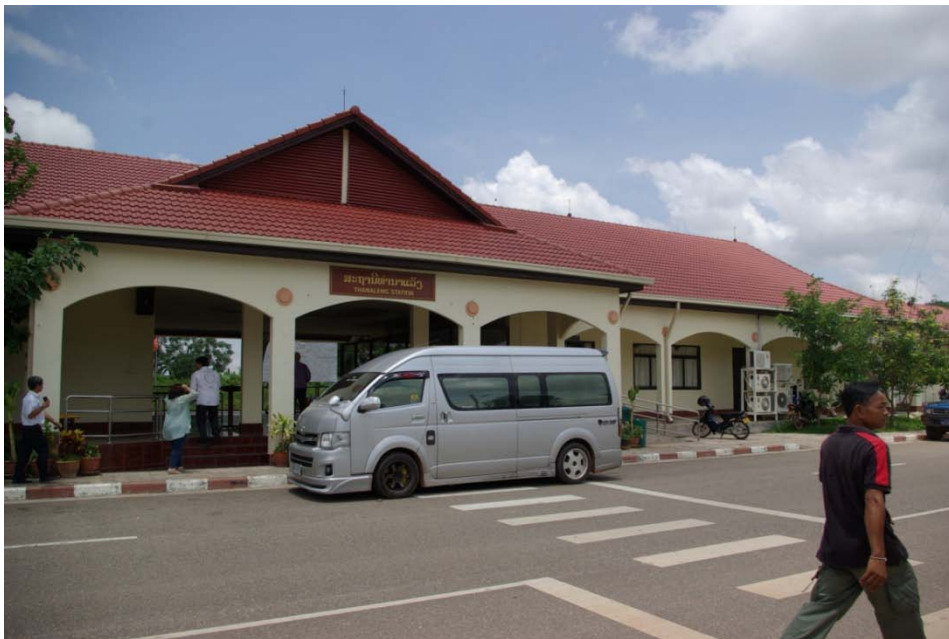
รูปที่ 2.6-5 สถานีรถไฟท่านาแล้ง สปป.ลาว บริเวณลานจอดรถด้านหน้า
