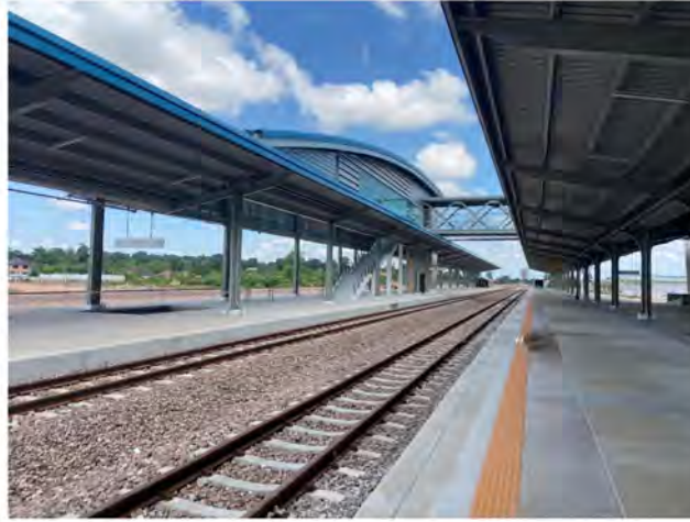
ภาพการก่อสร้างสถานีรถไฟเวียงจันทน์
