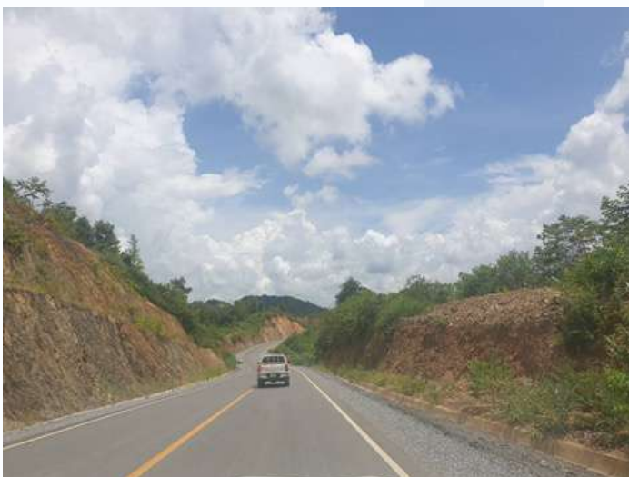
สภาพเส้นทางที่อยู่ระหว่างการก่อสร้างภายใต้โครงการ R11
