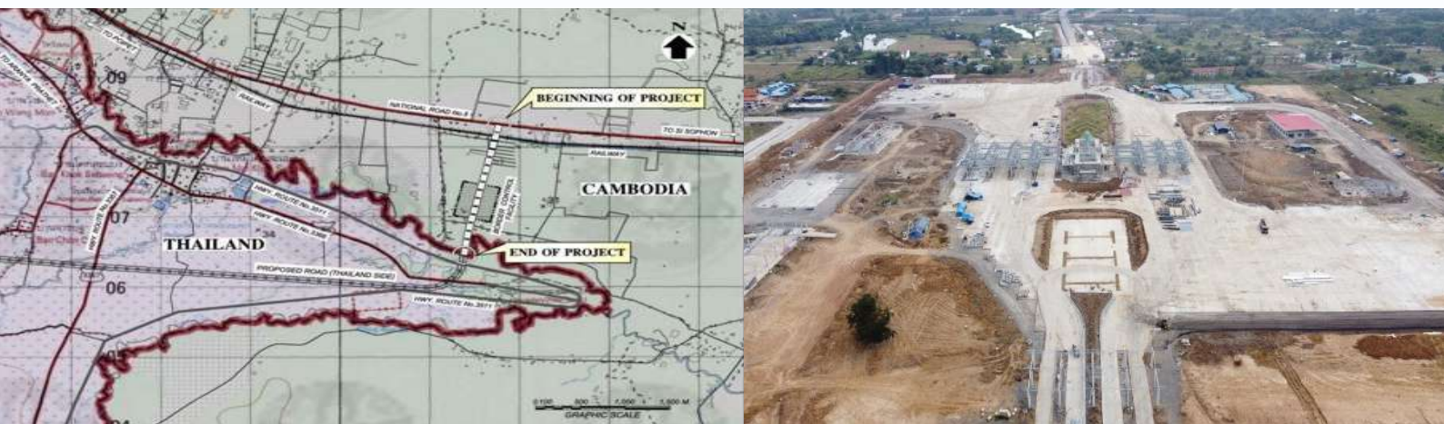
รูปภาพแสดงพื้นที่ดำเนินโครงการสติงบทฯ และพื้นที่ก่อสร้างโครงการสติงบทฯ ในส่วนของอาคารด่าน Border Control Facilities (BCF)
