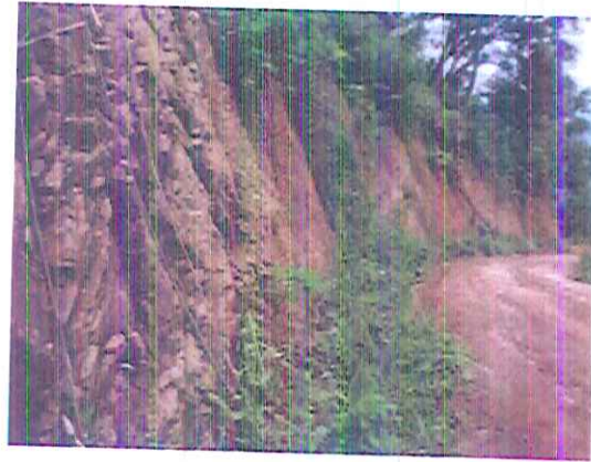
รูป 4.1-5 ลักษณะการวางตัวของหินทรายแป้งบริเวณกิโลเมตรที่ 24+200 มีการเอียงตัวไปทางตะวันตกเฉียงเหนือ ประมาณ 20 องศา (310/20) มีรอยการผุพังของชั้นหิน (Slaking) อย่างชัดเจน
