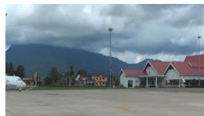
ลานจอดอากาศยาน (Apron)
