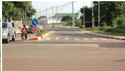
สภาพภายหลังการก่อสร้างแล้วเสร็จ
