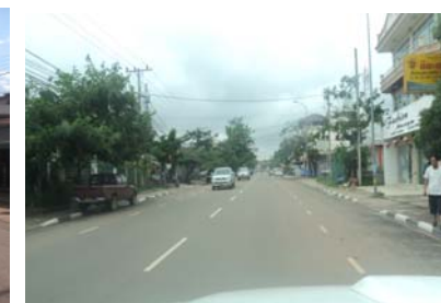
สภาพภายหลังการก่อสร้างแล้วเสร็จ
