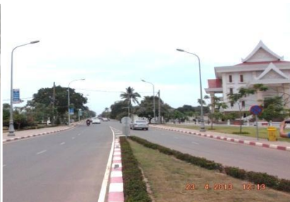
สภาพภายหลังการก่อสร้างแล้วเสร็จ (ปี 2556)
