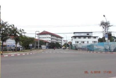
สภาพภายหลังการก่อสร้างแล้วเสร็จ (ปี 2556)
