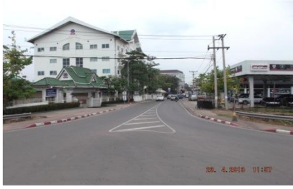
สภาพภายหลังการก่อสร้างแล้วเสร็จ (ปี 2556)
