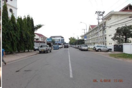
สภาพภายหลังการก่อสร้างแล้วเสร็จ (ปี 2556)
