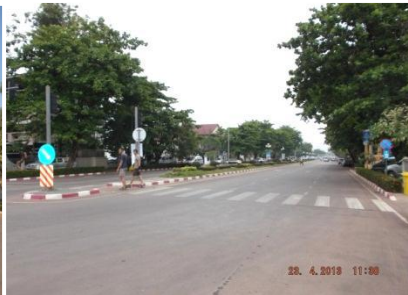
สภาพภายหลังการก่อสร้างแล้วเสร็จ (ปี 2556)
