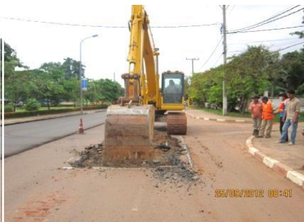
งานซ่อมผิวจราจร
