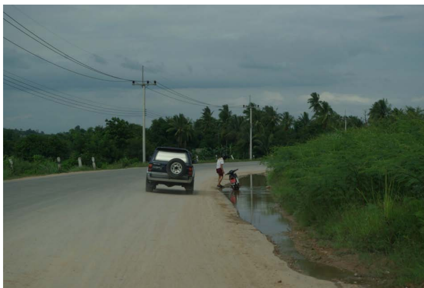
รูปที่ 3.2-1 น้ำท่วมขังบริเวณไหล่ทาง
